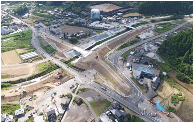
令和2年8月ごろの現場の様子。手前に小川橋、奥に南川橋が完成している。盛土は、水が流れやすいように傾斜をつけた水勾配になっている。
